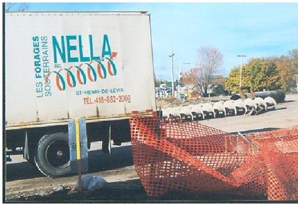
Camion de «Les Forages souterrains Nella, 18 octobre 1999
