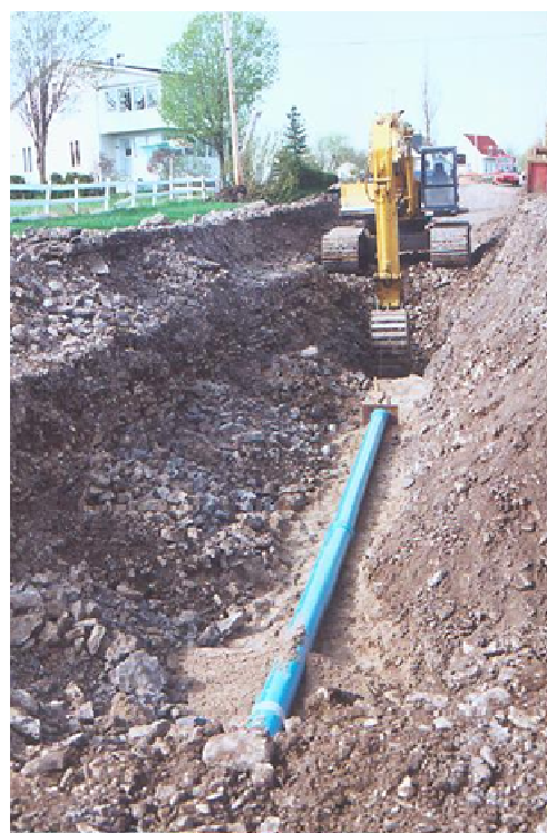
Travaux devant le 392 rue des Érables madame Rita Béland, 19 mai 2000
