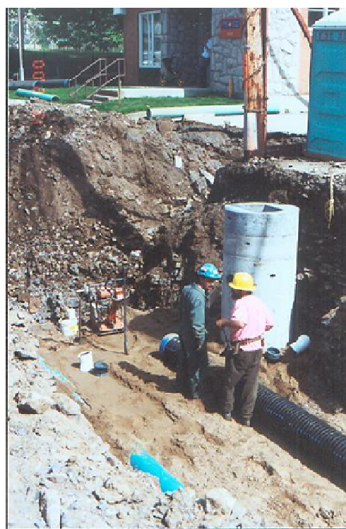
Travaux rue des Érables, 16 mai 2000
