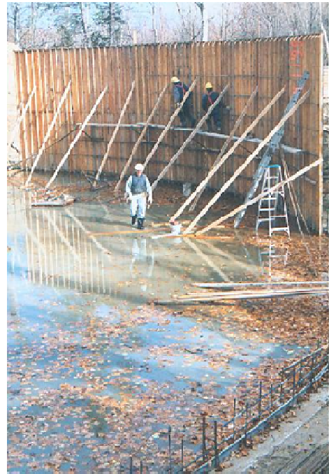
Construction d'un des bassins de décantation des eaux usées, 4 novembre 1999
